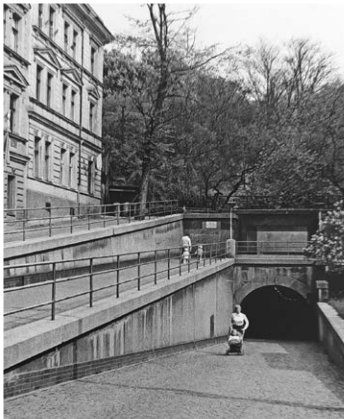
Tunel v 70. letech minulého století
